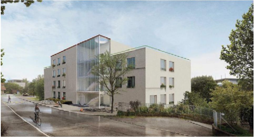
Abbildung 3 Ansicht Neubau von der Hühnerbühlstrasse
