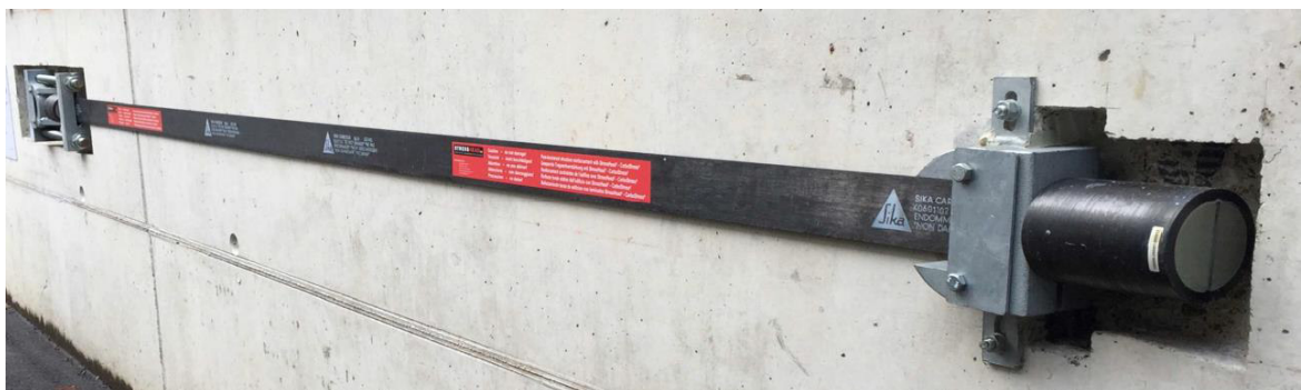
Abbildung 9: Stresshead-Verbindungselement
